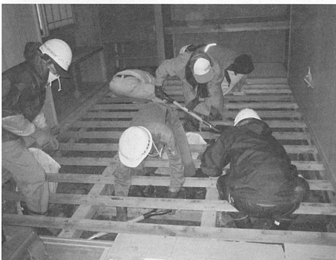
床を上げて、床下の泥を出します。腰に負担がかかります。
